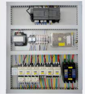
電控箱 Electronic control box
